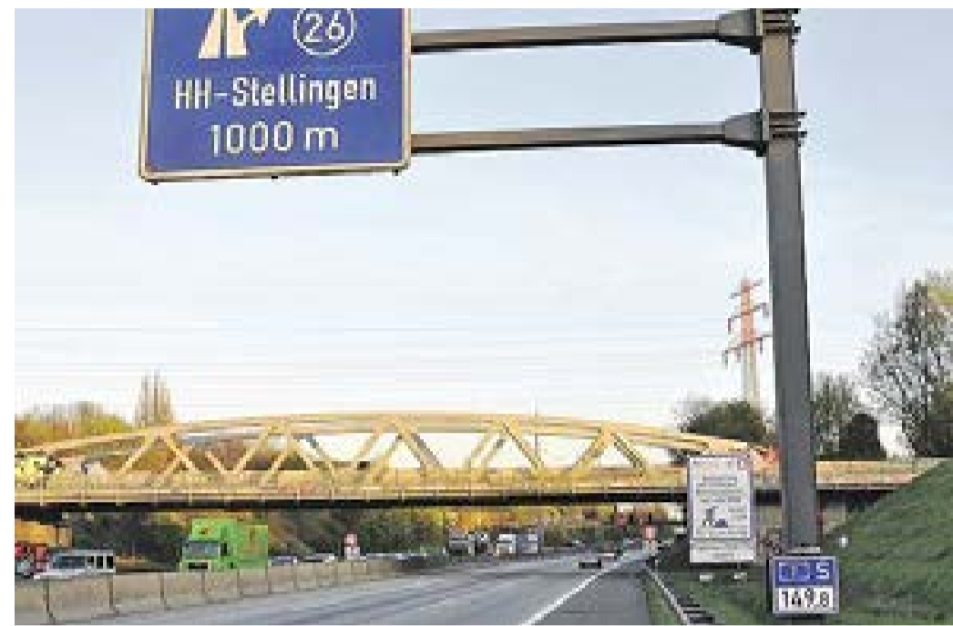
Das Hinweisschild für die Anschlussstelle Hamburg-Stellingen Nr. 26 wird bald der Vergangenheit angehören: Die A7 wird in diesem Abschnitt durch den Lärmschutztunnel Stellingen neu komplett gestaltet
