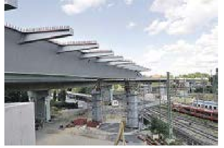
Die ersten Brückenpfeiler sind erreicht: Nach dem zweiten Vershub ruht die aufwendige Brückenkonstruktion auf den beiden Pfeilern außerhalb des Bahngeländes
