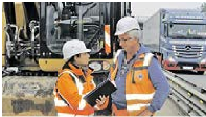
Routine bei hohem Verkehrsaufkommen: Bauführerin Ilhem Ouhaibi auf ihrer Baustelle in Schnelsen*
