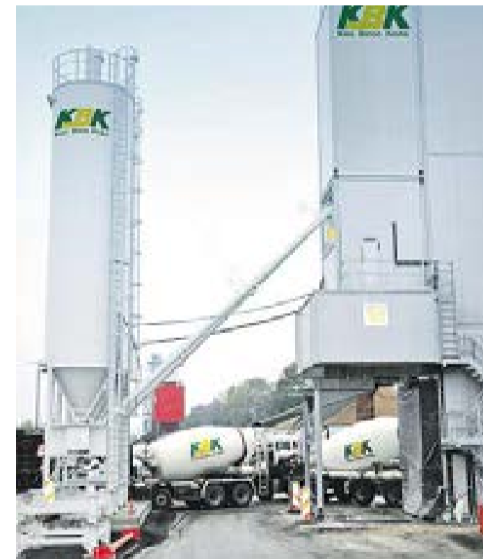
Direkt an der A7 Hamburg-Stellingen: Die neue Transportbeton-Mischanlage von KBK
