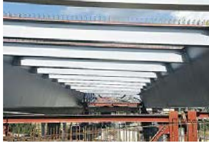
Die großen Stahltröge am Widerlager: Mit besonders ausgeführter Schweißtechnik werden die Stahlträger mit den Trapezhohlkästen verbunden
