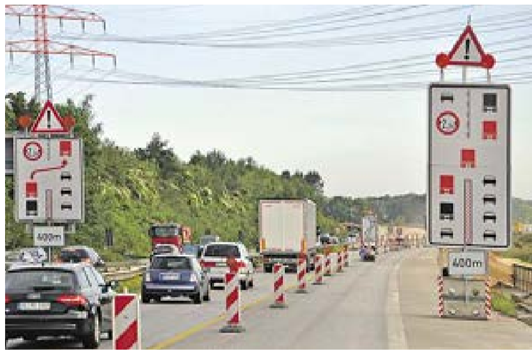
Durch Wegweistafeln zum Reissverschluss-System gelingt eine übersichtliche Verkehrsführung in Richtung Hamburg: Die Verkehrsteilnehmer werden damit im einspurigen Bereich bei Schnelsen auf der A7 auf partnerschaftliches Verhalten und Fairplay hingewiesen
