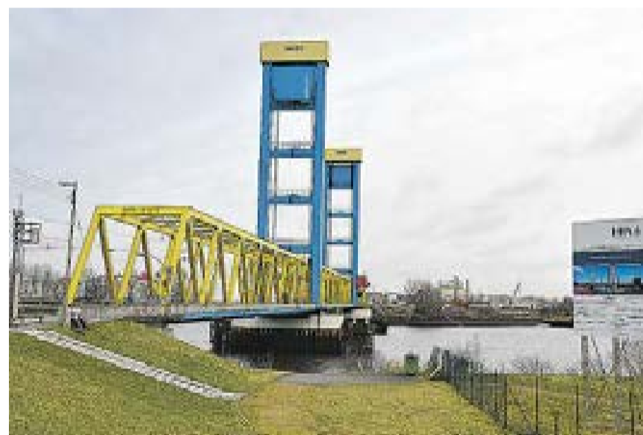
Die in den 70-er Jahren errichtete Kattwykbrücke wird modernisiert: Planung und Ausführung für die Errichtung eines zweigleisigen Ersatzbauwerkes sind aufgenommen für die wichtige Querung über die Süderelbe im Hafen.
