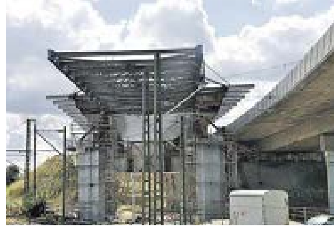
Erster Vershub der Brücke: Mit spezieller Vershubtechnik wird die Stahlverbundbrücke über die Hilfsstützen geschoben
