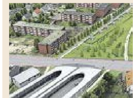
Erkennbare Tunnelausmaße am Portal Nord: Die A7 wird hier komplett mit einer Park- und Grünanlage überdeckt
