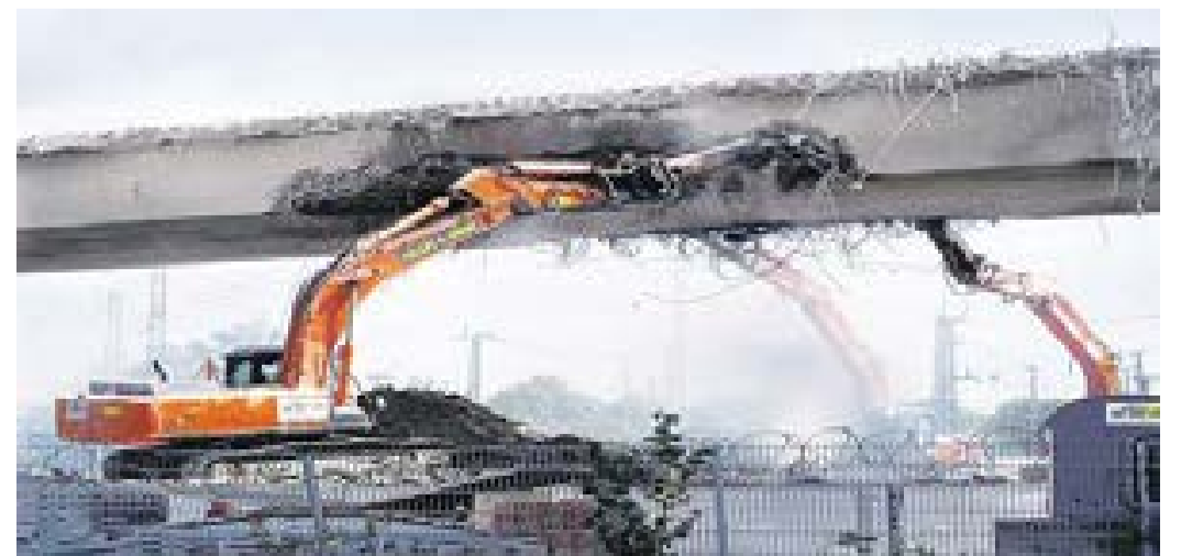
Ehlert & Söhne mit bis zu sieben Baggern vor Ort - Abbruch der A7-Autobahnbrücke Stellingen August 2014 bis voraussichtlich Dezember 2015
