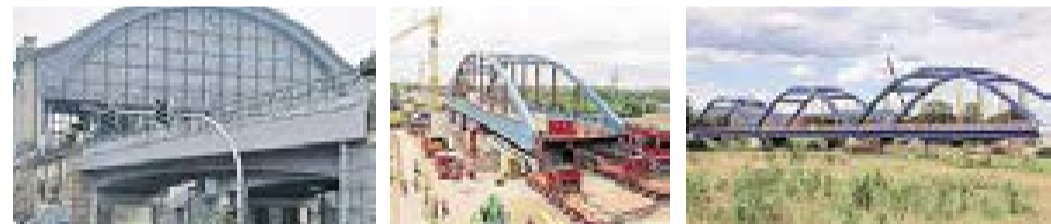
Drei Schmuckstücke: Die massive Stahlkonstruktion Dammtorbrücke in Hamburg (l.), die Eisenbahnbrücke über die A3 in Erlangen und die Mainbrücke Wiesen
