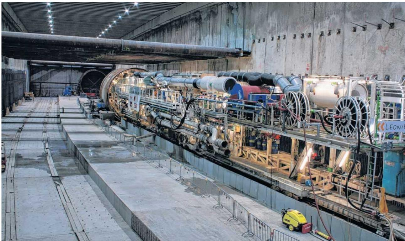
Tunnelbohrmaschine Leonie übernimmt den gesamten Vortrieb und gleichzeitig den Tunnelbau. Sie arbeitet sich bei der Untertunnelung bis in 22 Meter Tiefe vor. Dabei bekommt sie es mit zehn verschiedenen geologischen Schichten zu tun.
