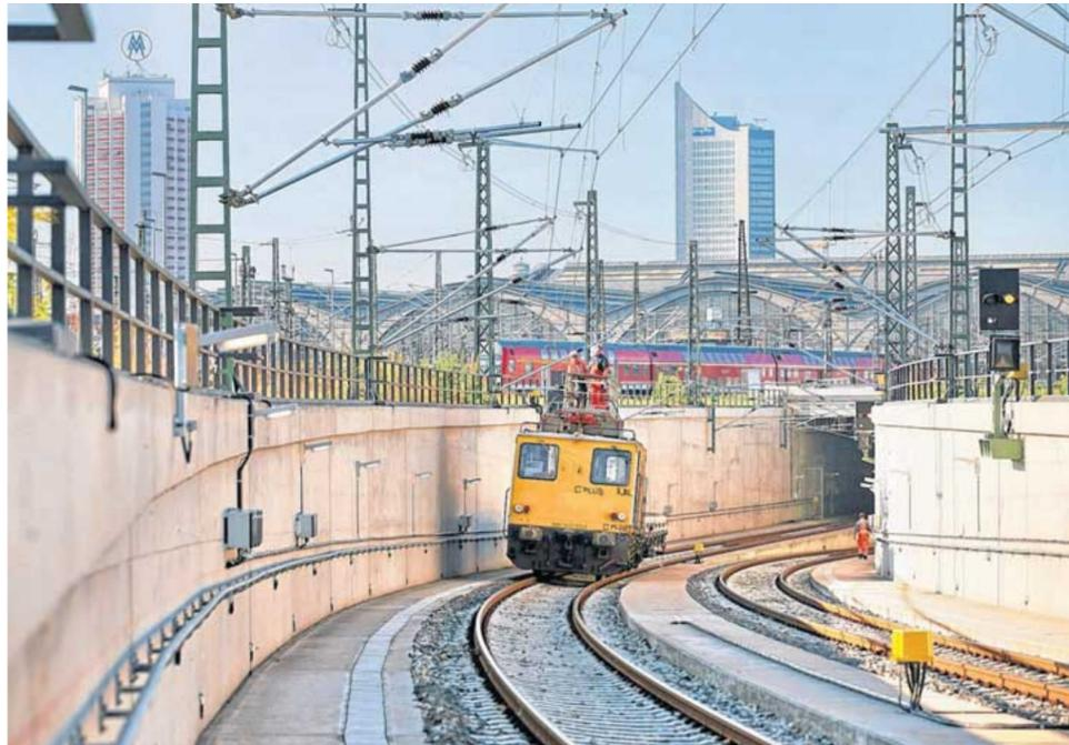
Die letzten Handgriffe: Mit der Installation der Fahrleitung auf der Tunnel-Rampe am Hauptbahnhof geht der Bau in die Endphase. Foto: dpa
