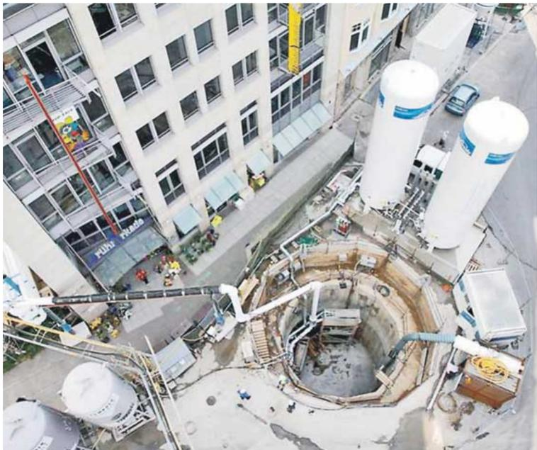
Blick in den Schacht der Baugrube des Marriott-Hotels. Riesige Mengen an Stickstoff werden von Linde direkt an die Baustelle geliefert und in vakuumisolierten Tanks zwischengelagert. Foto: Frank Eritt
