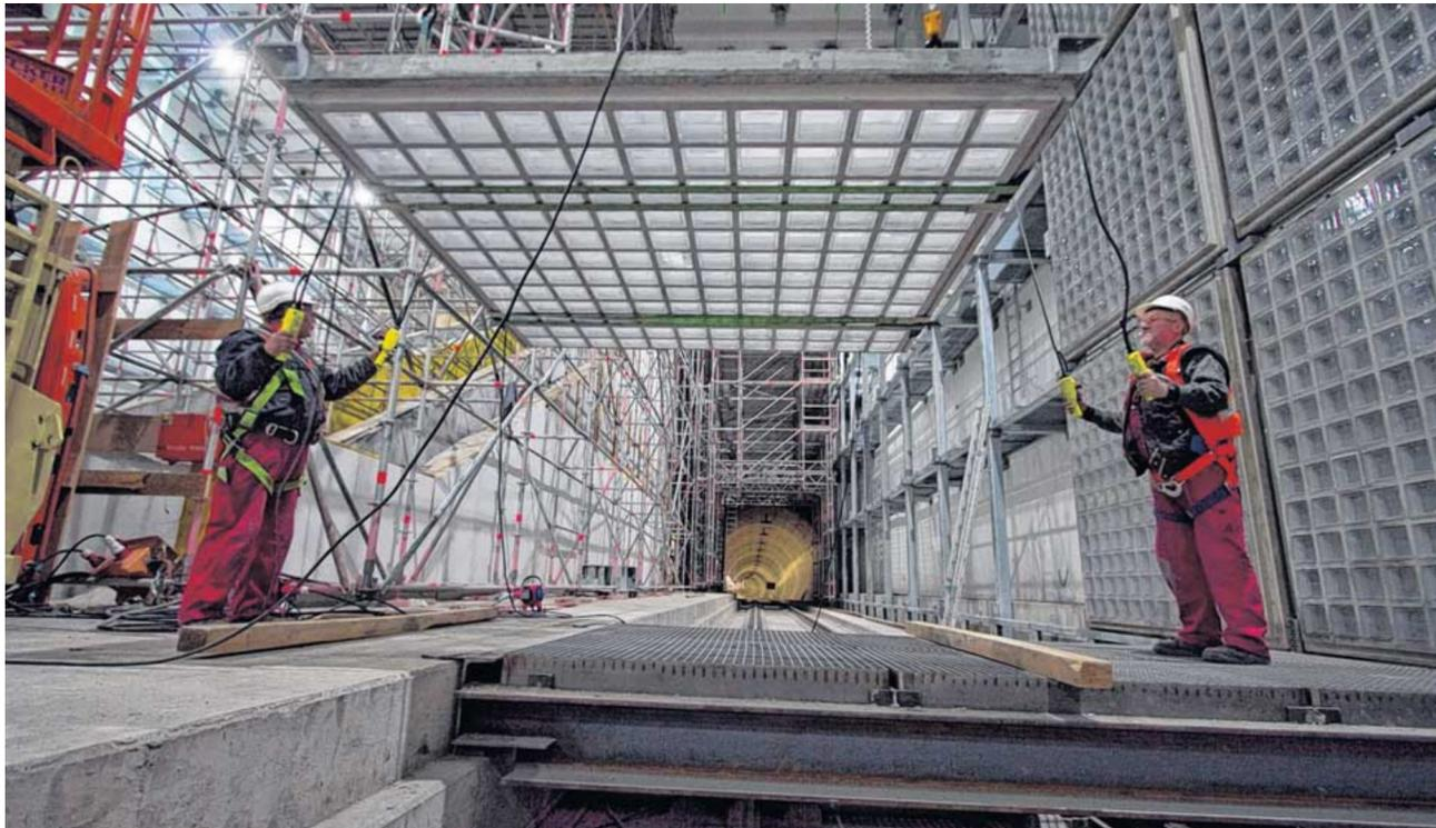
Mithilfe von sogenannten A-Böcken werden die 1,5 Tonnen schweren Glasbaustein-Elemente einzeln in die Höhe gehoben. Dort werden sie von den Arbeitern an die Decke montiert. 900 dieser Glasbaustein-Elemente hat die Ed. Züblin AG in der Station Wilhelm-Leuschner-Platz an Decke und Wänden befestigt. Foto: Frank Eritt
