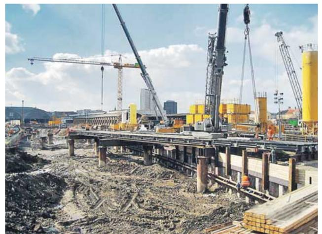
Bei den Arbeiten am Bau des City-Tunnels entsteht der längste Hilfsbrückenzug, der bisher bei der Deutschen Bahn eingebaut wurde. Foto: SSF Ingenieure
