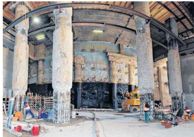
Während der Tunnel unter dem Hauptbahnhof ausgegraben wird, halten zwei künstliche, rückverankerte Eiswände den Erd- und Wasserdruck.
