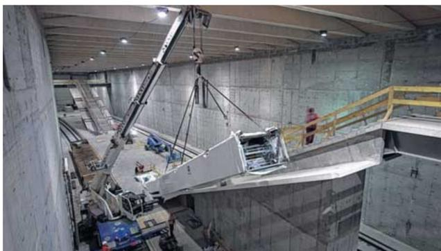
Ein Autokran, der sich auf einem Bahnwagen befindet, hebt die Teile der Fahrtreppe vom Markt in die Position zum Befestigen. Foto: Frank Eritt
