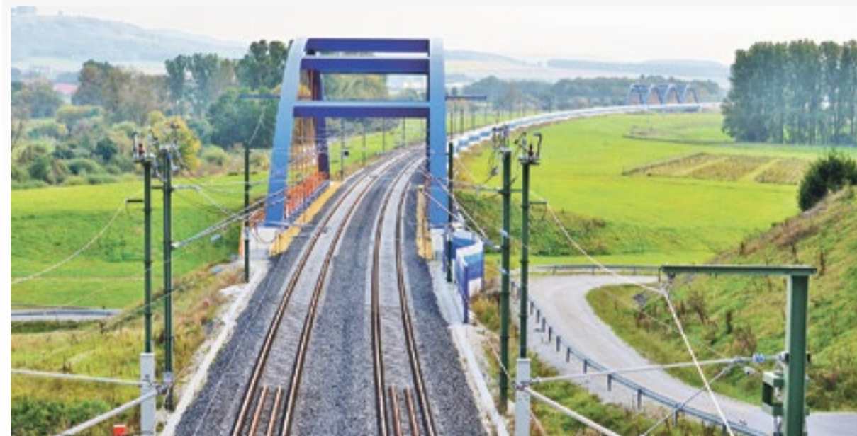
Im Brückenbau ein gefragter Partner beim Bahn-Großprojekt: Die Unternehmensgruppe BUNG war an der Planung und Überwachung von insgesamt sieben Brücken der Schnelltrasse beteiligt.
