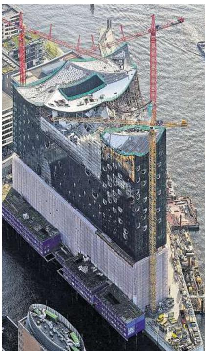
ersten Montagephase möglich machten. Nach zwei Kletterphasen wurden die Endhakenhöhen der Turmdrehkrane erreicht. Während der Einsatzzeit der Krane mussten die Anbindungen am Gebäude wegen der speziellen Glasfassadenmontage mehrmals den Anforderungen entsprechend umgebaut werden. Die Einsatzdauer war mit 24 Monaten veranschlagt.
